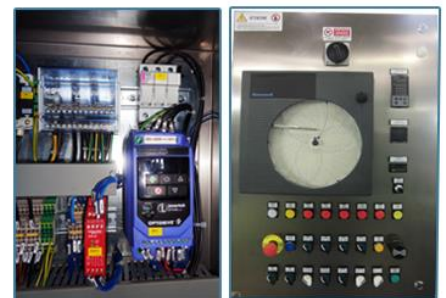
Quadro con sistema di registrazione elettronica della temperatura con display videografico
